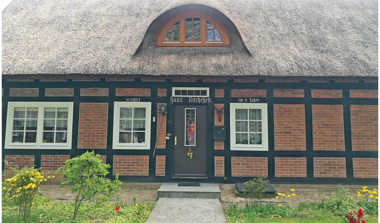
Eines der Häuser von Alt-Rehse, den „Gauen“ zugeordnet: hier Kurhessen, errichtet im Jahr drei des „Tausendjährigen Reiches“ (1936).
